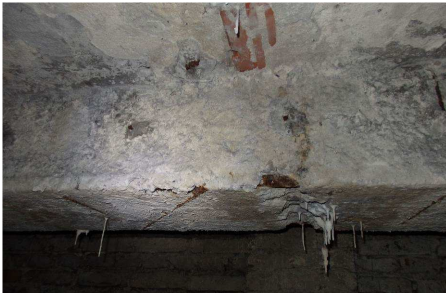
Fot. 6. Widok fragmentu podciągu przeznaczonego do reprofilacji
